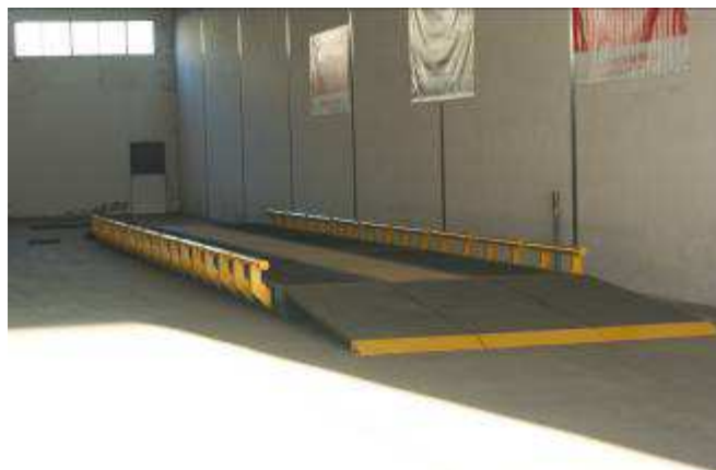
- Báscula Puente PCM SG sobre suelo con rampas metálicas.
