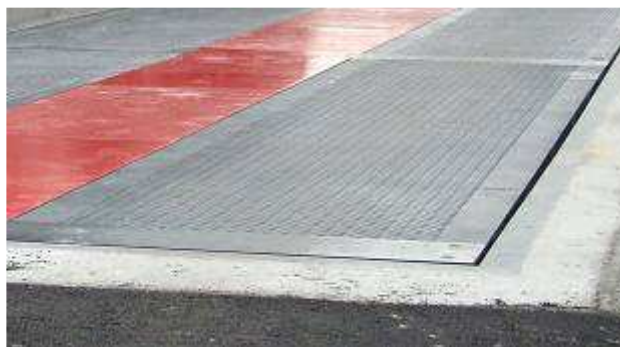
- Módulo metálico montado en una Báscula PCM SG empotrada.
