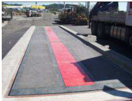
- Báscula Ponte PCM SG empotrada con módulos de hormigón.
