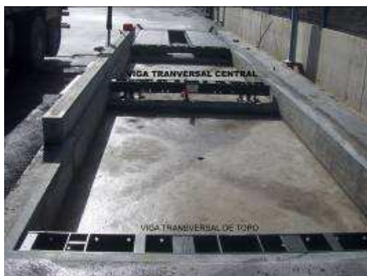
- Vigas transversales de testeros y centrales montadas y preparadas para ser instalados los módulos.
